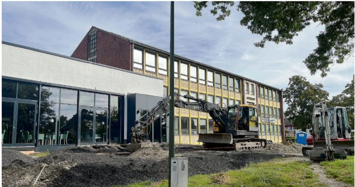
Endlich geht der Umbau des Stadtmuseums weiter: Die Bagger sind angerückt, um das Außengelände umzugestalten.
