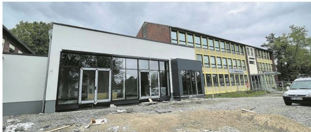
Der neue Museumsanbau ist fertig – zumindest von außen.
