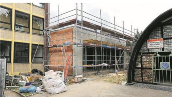
Das neue Gebäude nimmt langsam Gestalt an.
