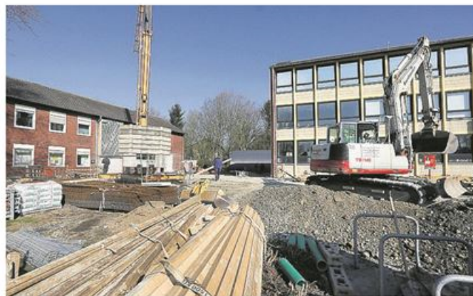
Das Stadtmuseum ist nicht mehr nur im übertragenen Sinne eine Baustelle: Die Bauarbeiten für den Anbau haben begonnen.
