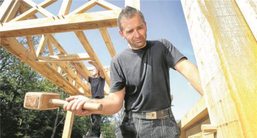
Das Nordtor soll aus Eichenbalken mit alten Handwerkstechniken nachgebaut werden, wie sie auch schon in der Antike bei den Römern üblich waren. Erfahrungen hat der Museumsförderverein damit schon beim Nachbau der Holz-Erde-Mauer gesammelt.
